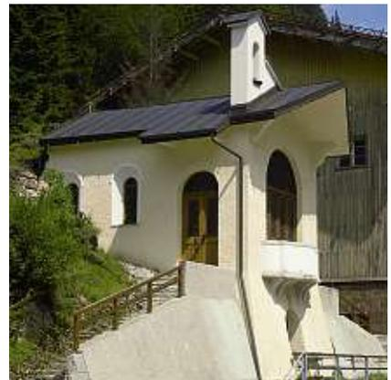
Quer zum gewachsenen Felsen mit dem Votivbild wurde ein kleiner Rechteckraum nach Osten hin angebaut. Der Kapellenraum wird durch zwei Gurtbögen räumlich zониert und von zwei Freitreppen erschlossen. Für eine Feldmesse ergibt sich dadurch ein Durchgangsraum mit einem davor liegenden Balkon.
